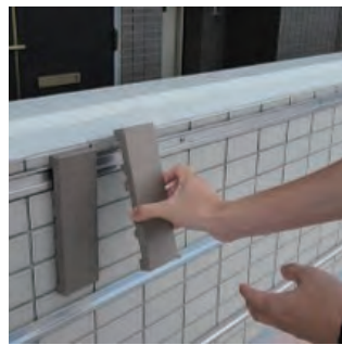
図2 乾式タイル取付の様子
