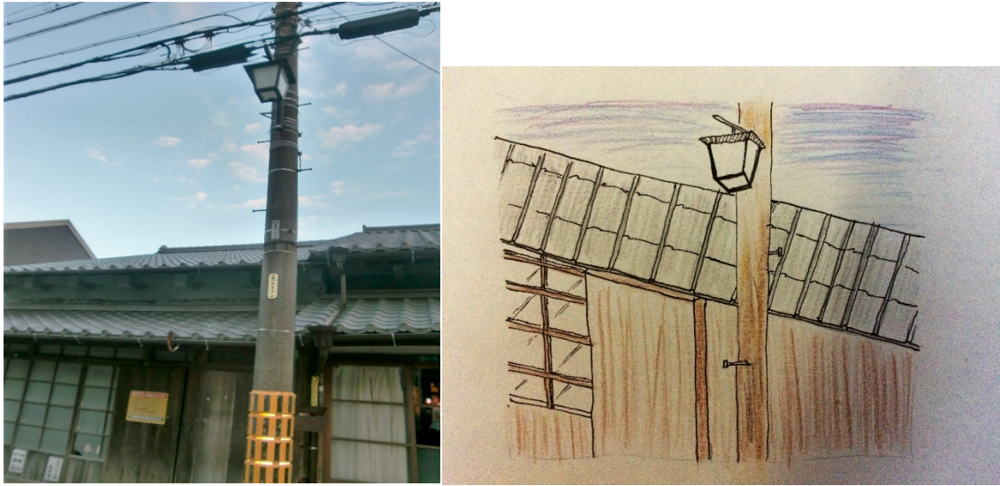
図5 元の電柱と街灯 ⇒ 電柱と街灯が景観に馴染む
